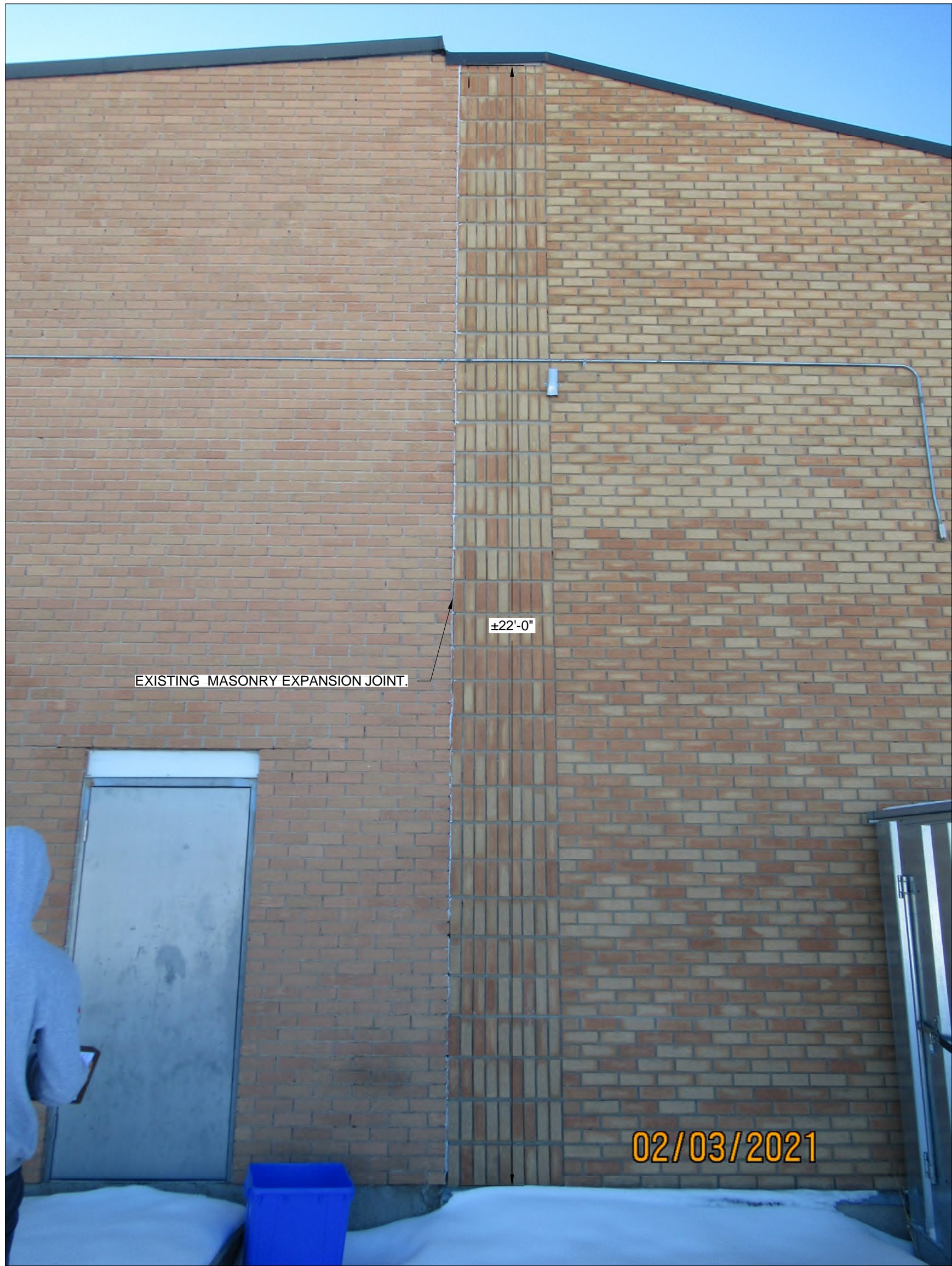
NORTH MASONRY JOINT SCALE: N.T.S.
