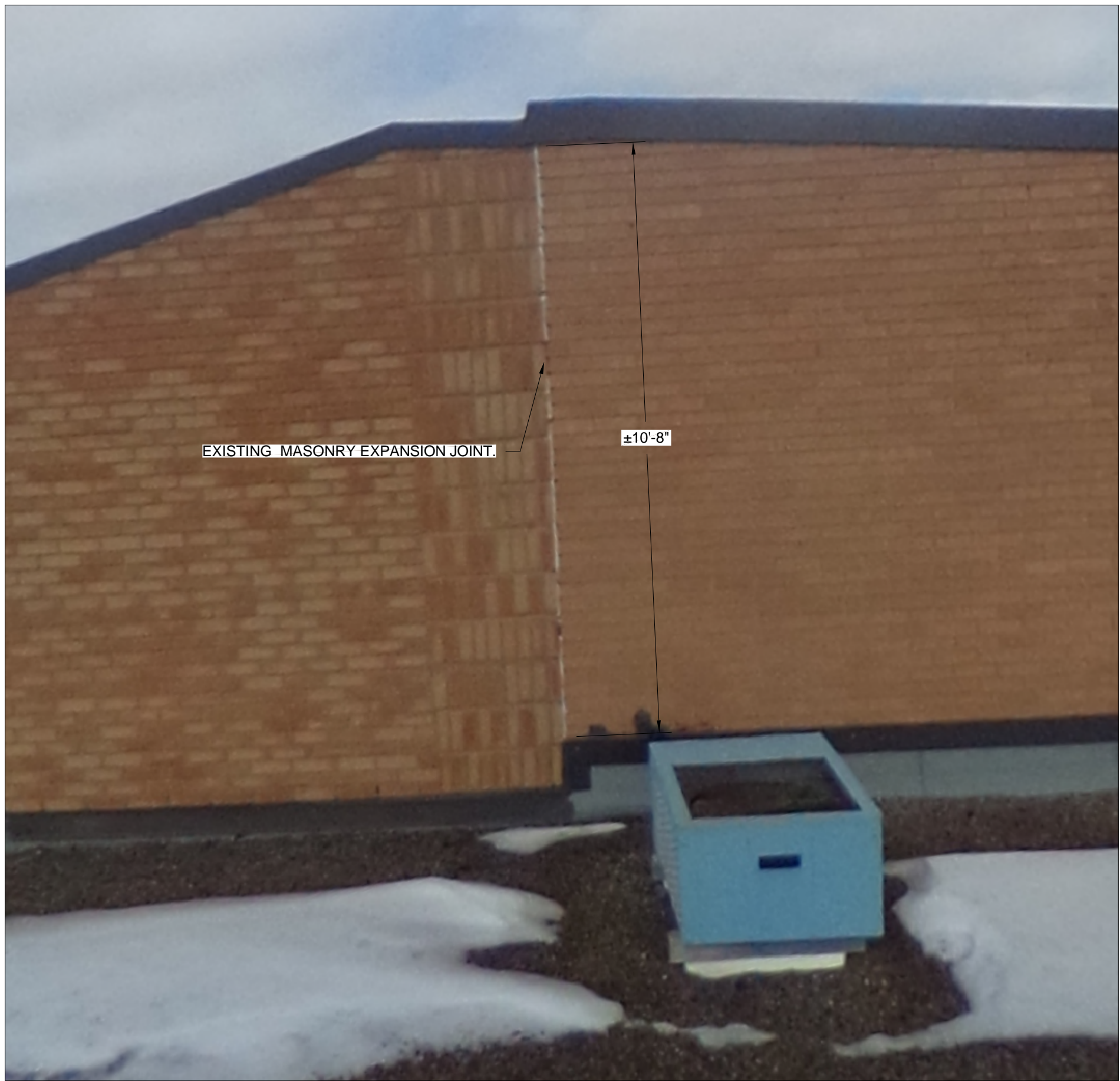
SOUTH MASONRY JOINT SCALE: N.T.S.
